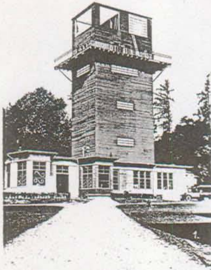
Ill. 33 - Vue de la tour
