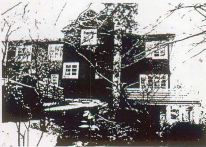
Ill. 20 - Prise de vue actuelle de la façade nord-ouest de l'entrée
