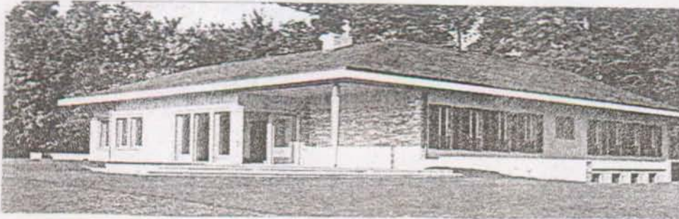
Ill. 19 - Les murs côté terrasse sont en pierre et les caissons de store revêtus d'un placage de bois.
