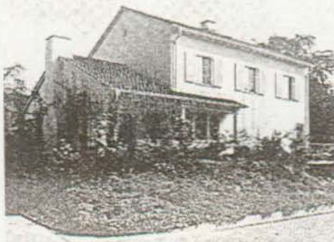
Ill. 4 - Maison de l'architecte, alte Landstr., Zollikon, ZH, 1950-1952 in: catal. d'exposition p. 142
