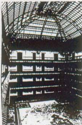
Ill. 5 - Vue intérieure du bâtiment central dont la toiture métallique a été reconstruite après la guerre. in: Erwin Mühlestein, cf. ill. 3, p. 25
