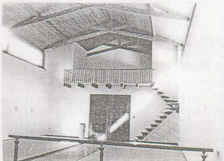
Ill. 9 - Vue de l'intérieur de la chapelle en direction de la galerie
