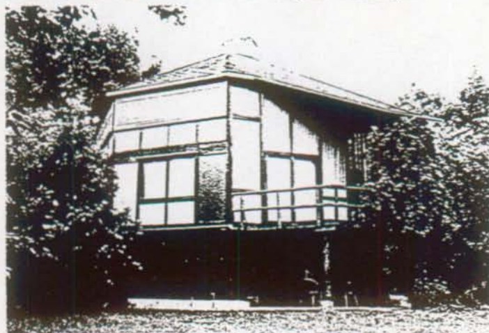
Ill. 21 - Vue de la façade côté lac Photo actuelle de Evelyne Lang
