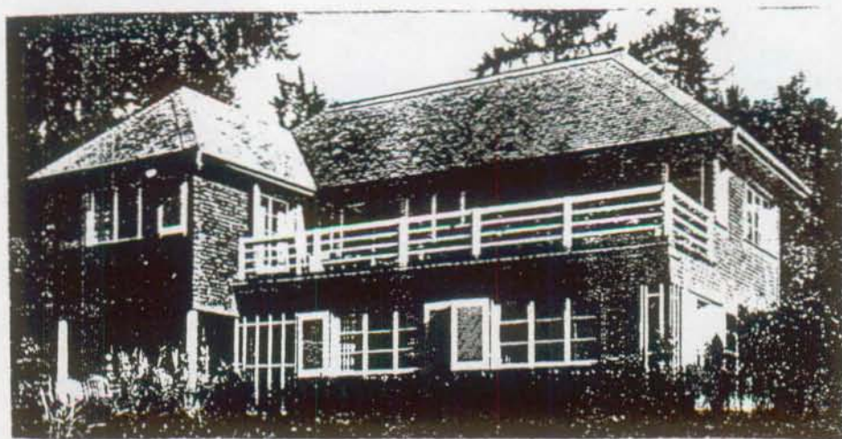
Ill. 16 - Vue détaillée de la façade sud in: catal. d'exposition p.37
