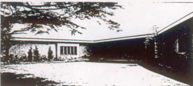
Ill. 22 - Façades ouest / sud-ouest, sud-ouest (esp. jour)/ sud-est(esp. nuit), et nord-ouest
