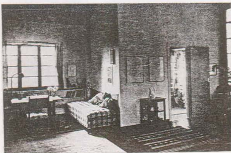
Ill. 6 - Vue de l'atelier en direction de la niche est. in: Werk, p. 366
