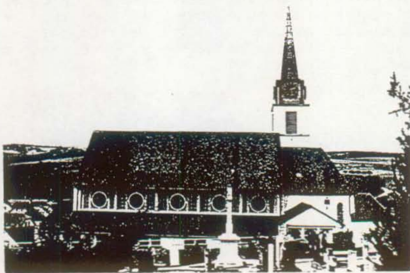
Ill. 9 - Vue de la façade sud de l'église
