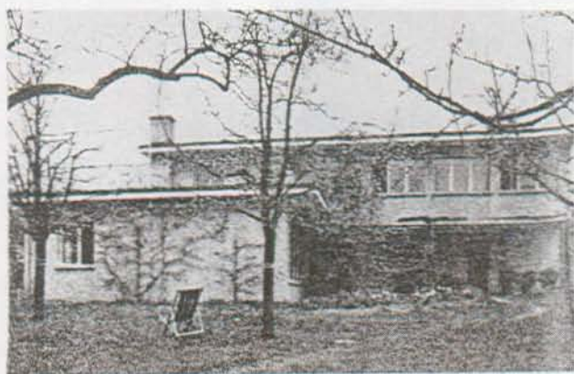
Ill. 15 - Vue de la face sud de la maison in: Werk, p. 1.
