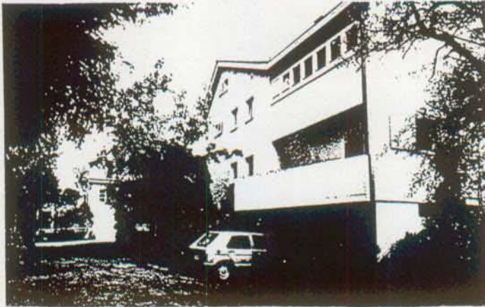
Ill. 3 - Vue de la façade d'accès
